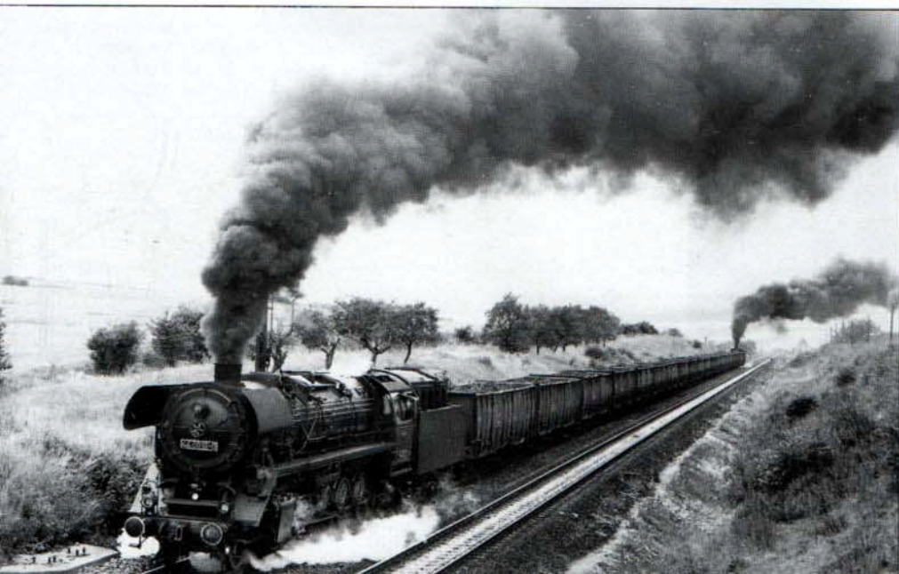
5: Una vista desde la caseta de enclavamientos de Steinberg: la 44 0018 y la 44 0278 subiendo la rampa con una carga de 1.300 toneladas.
