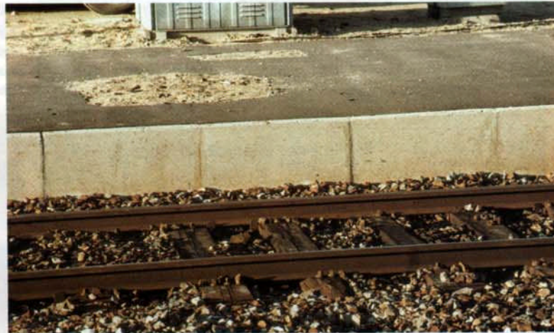
3. Andén de perfil bajo, de 300 mm, realizado recientemente con bordillos de hormigón.
