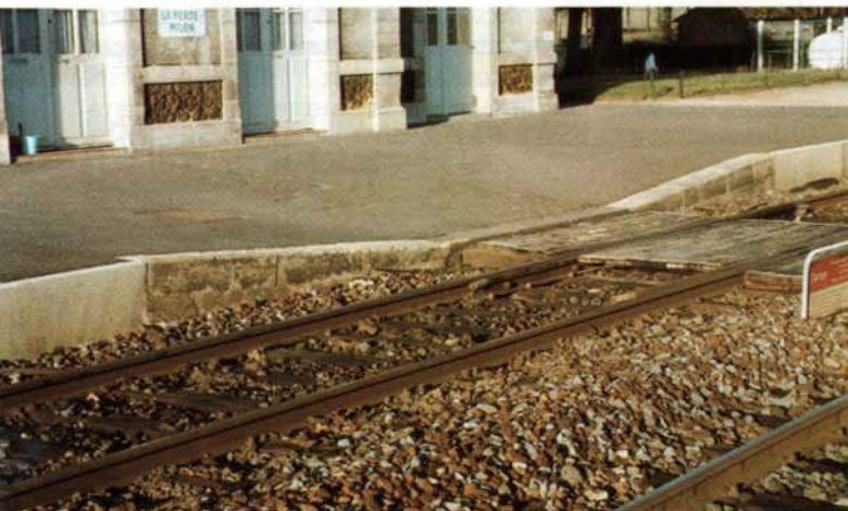
2. Inflexión característica de un andén, al nivel de un paso con traviesas.
