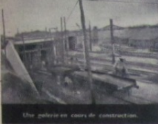
Une galerie en cours de construction.
