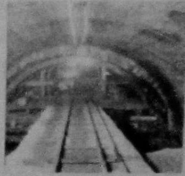
3. Vue des premiers anneaux de la voûte, au fond, la route ancienne mise sur chantier avant inspection.
