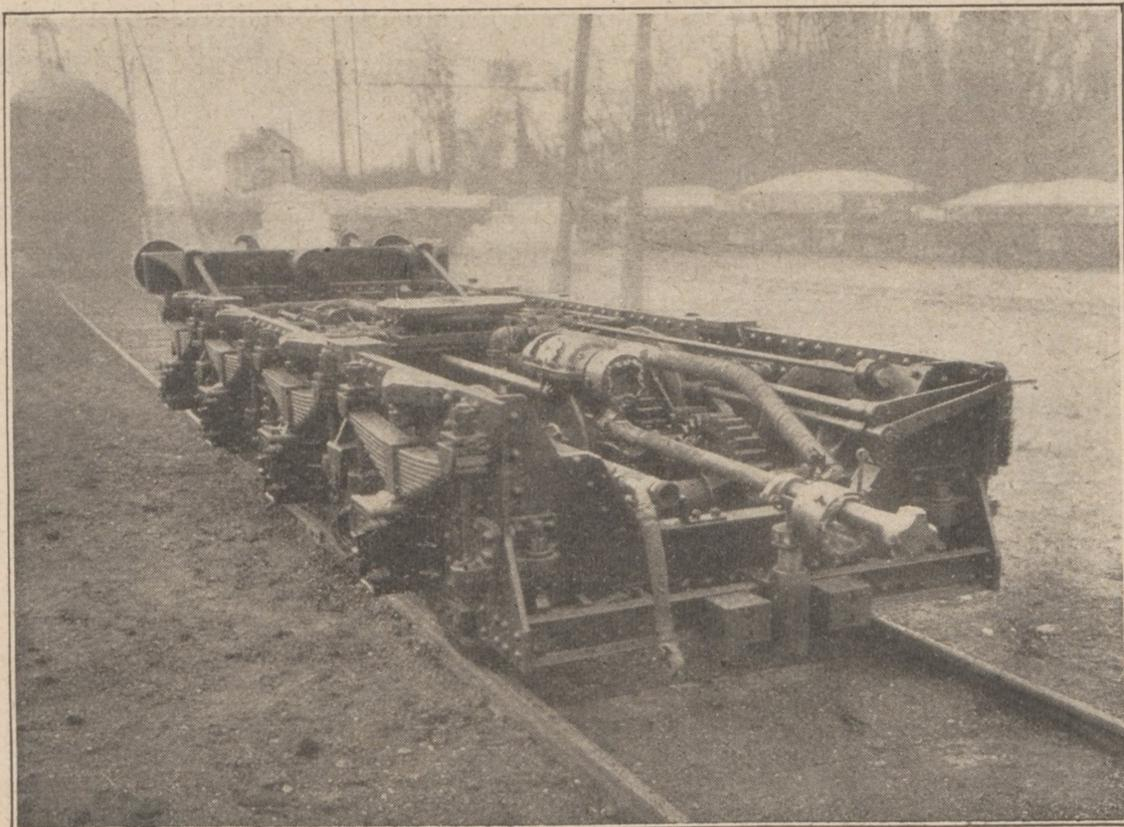
2 essieux par bogie par l'intermédiaire de réducteurs à vis sans fin, sous carter étanche, et de pignons coulissants débrayables. L'attaque du réducteur est effectuée par un arbre à trèfles
