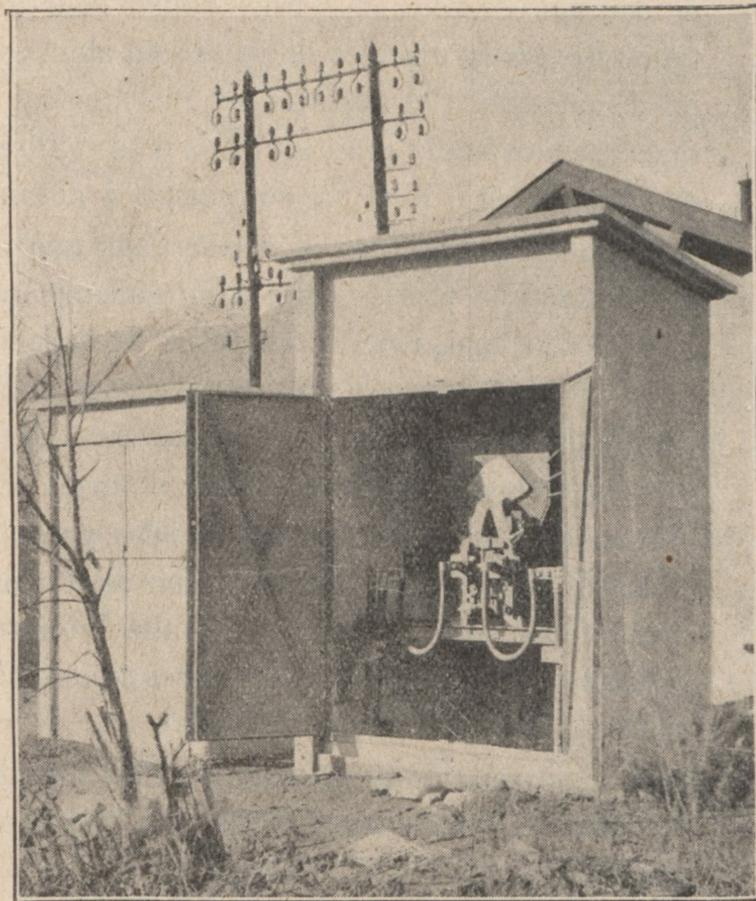
En général les appareils de nature différente (sectionneurs, contacteurs, disjoncteurs) sont installés dans des cabines distinctes, chaque poste comprenant une ou plusieurs cabines. Cette disposition a permis de réduire le nombre des types de cabines, et, par conséquent, de construire ces dernières en série. Elles sont formées de panneaux en ciment armé, confectionnés à l'atelier et assemblés sur place (Fig. 17).
