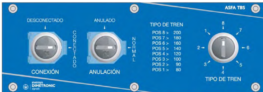
Figura 3-8 Módulo de Selectores
