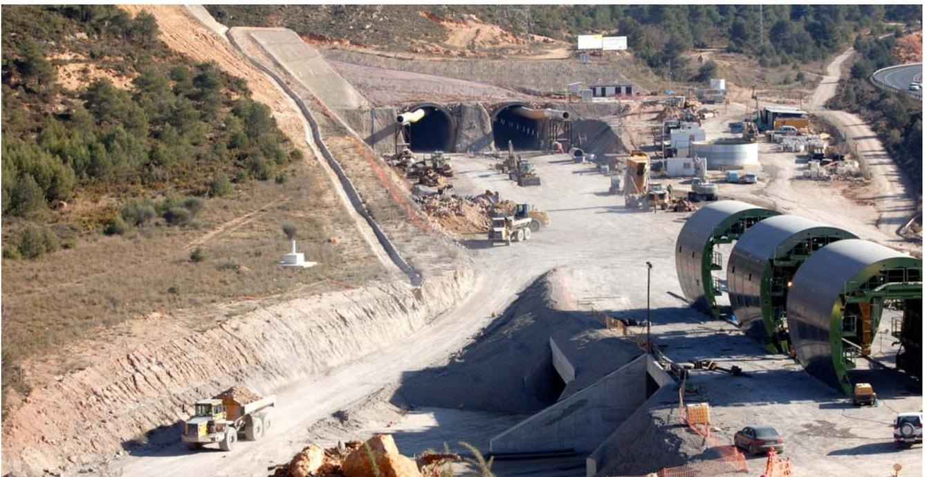
Lado oeste del túnel de La Cabrera. En diciembre de 2007, momento de la fotografía, la tuneladora trabajaba incesantemente horadando el túnel de la izquierda. Foto Enrique Andrés.
