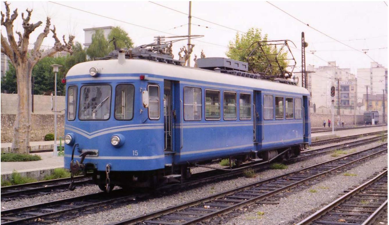
Entre 1979 y 1982 se reconstruyeron en los talleres de Pont de Fusta utilizando los chasis, equipos eléctricos y de rodadura algunos automotores «bujías» y un «cincuenta», tratando de dar una imagen de modernidad al obsoleto parque móvil. El número 15 espera en Pont de Fusta el inicio de servicio hacia Bétera. Año 1981. Foto Enrique Andrés.
