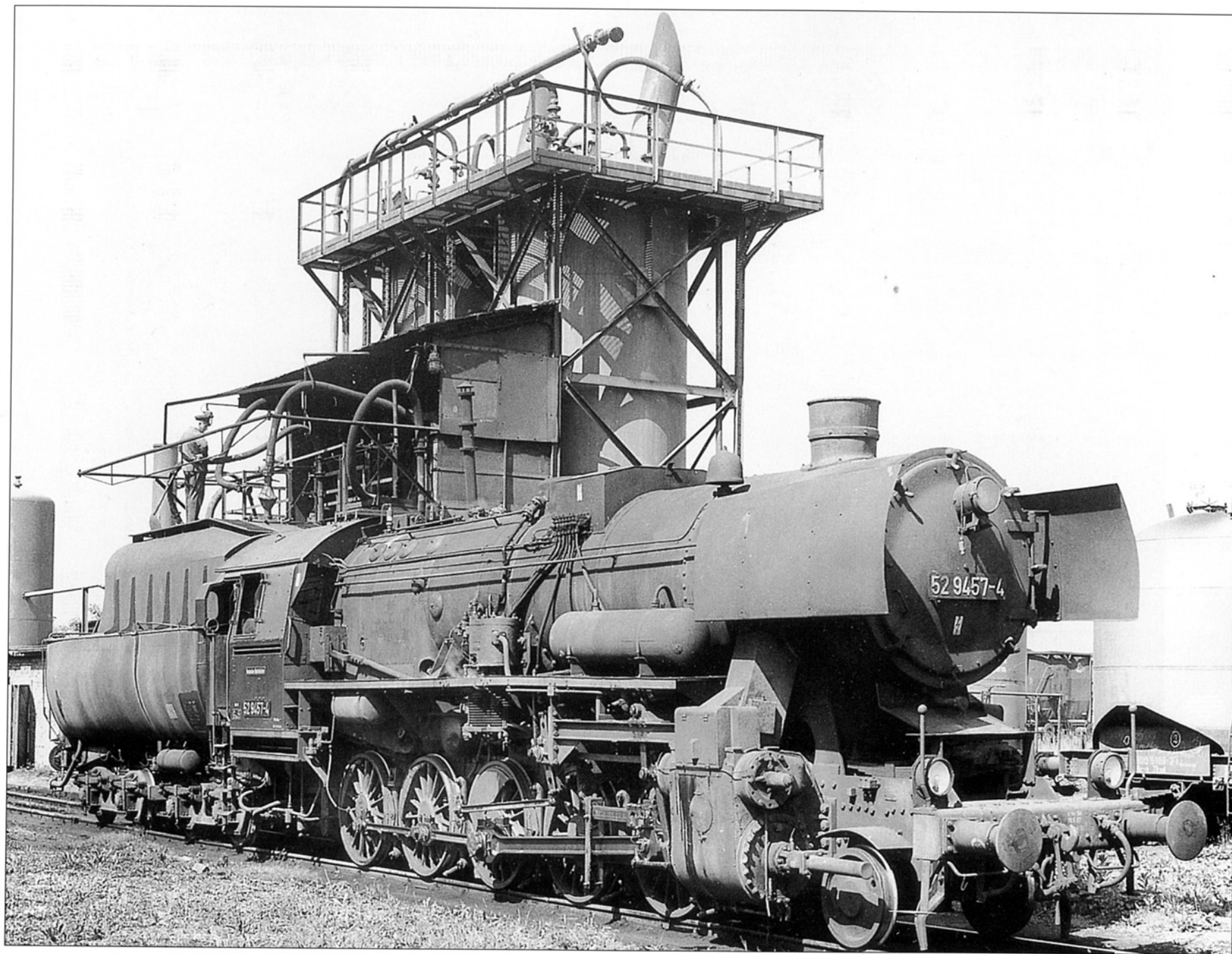
На этом снимке, сделанном в июне 1973 года, показан процесс заправки тендера паровоза № 52 9457 в депо Зенфтенберг из бункера хранения угольной пыли.
