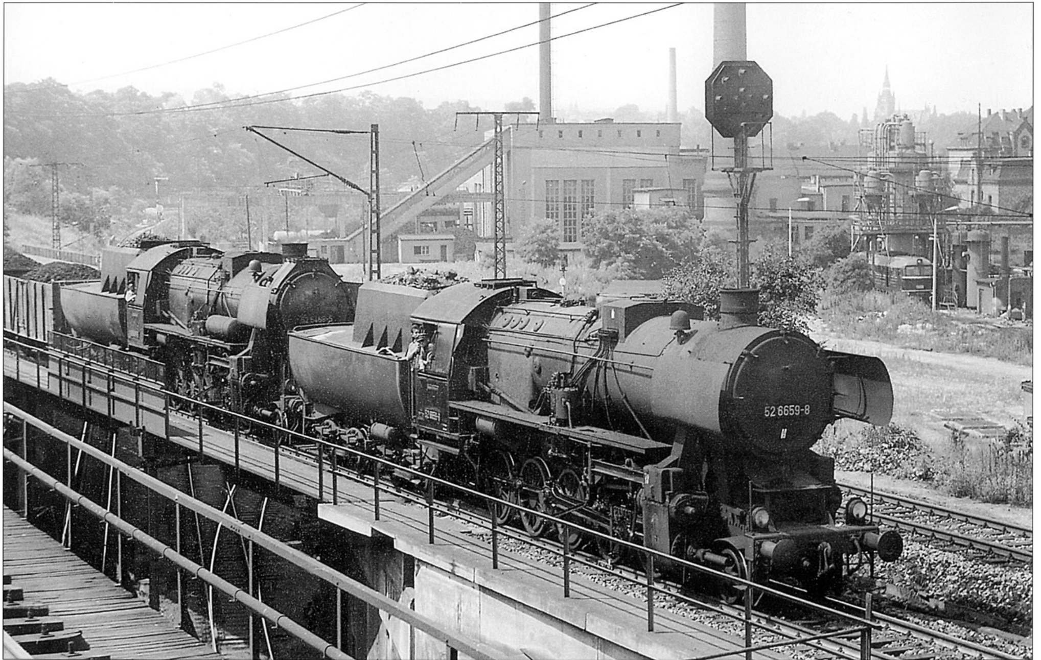
На этой фотографии, сделанной в Дрезден-Фридрихштадт 31 июля 1971 года, можно сравнить паровозы старой постройки (№ 52 6659) и серии 52-GR (№ 52 5468), последний отличался наличием баллона со сжатым воздухом и смешанного подогревателя первоначального типа.
