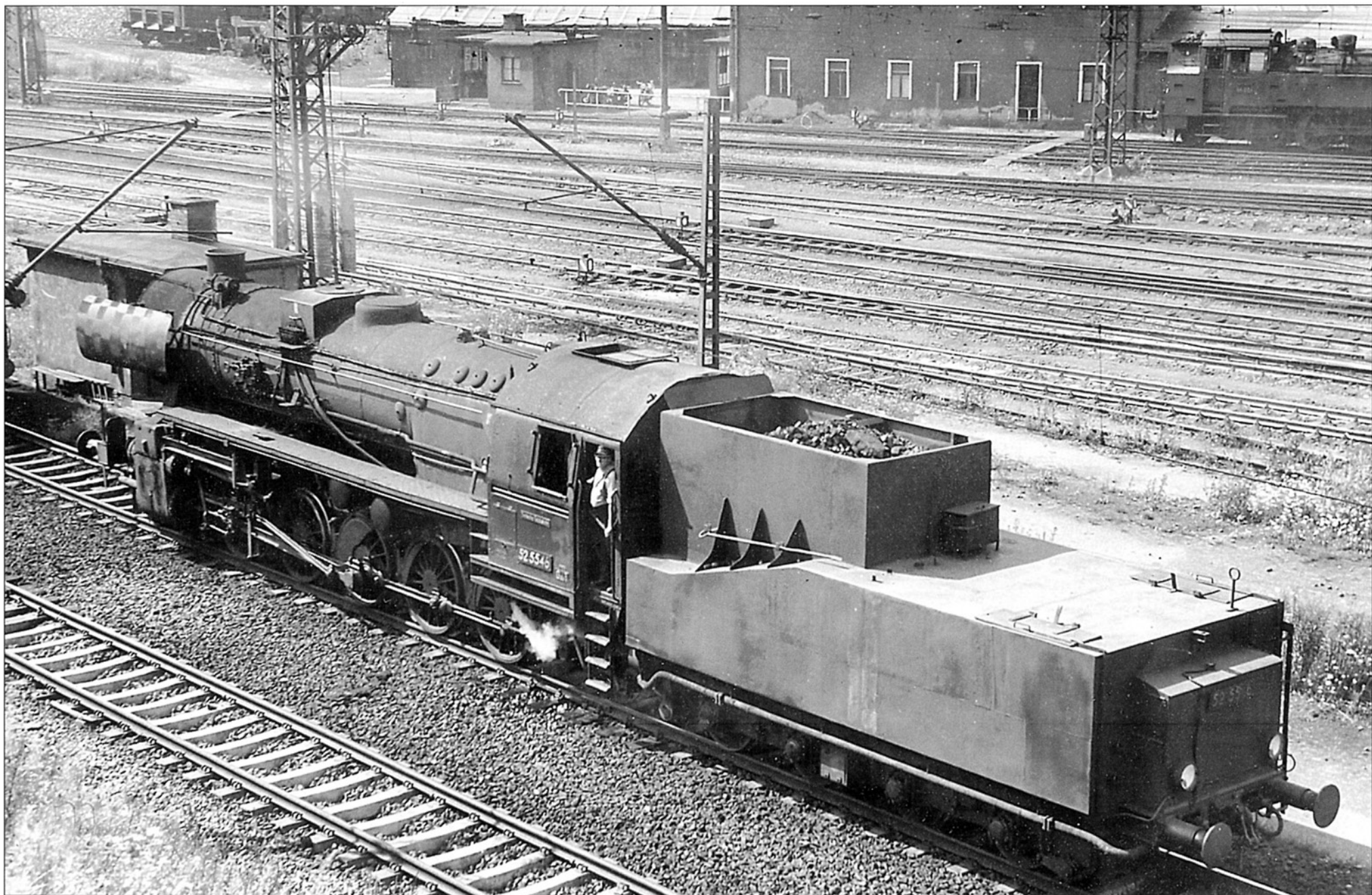
Вид на паровоз № 52 5546 с тендером на жесткой раме. Цвикау, 30 июля 1967 года.
