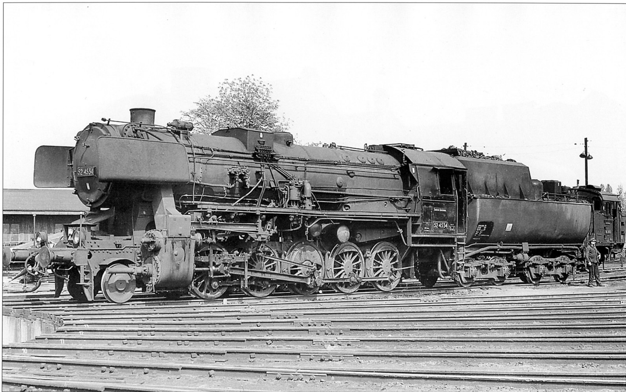
Некоторые паровозы 52-й серии были оснащены котлом с поверхностным подогревателем. Позже они были заменены обычными парогенераторами. Снимок паровоза № 52 4534 сделан в Баутцене в мае 1969 года.
