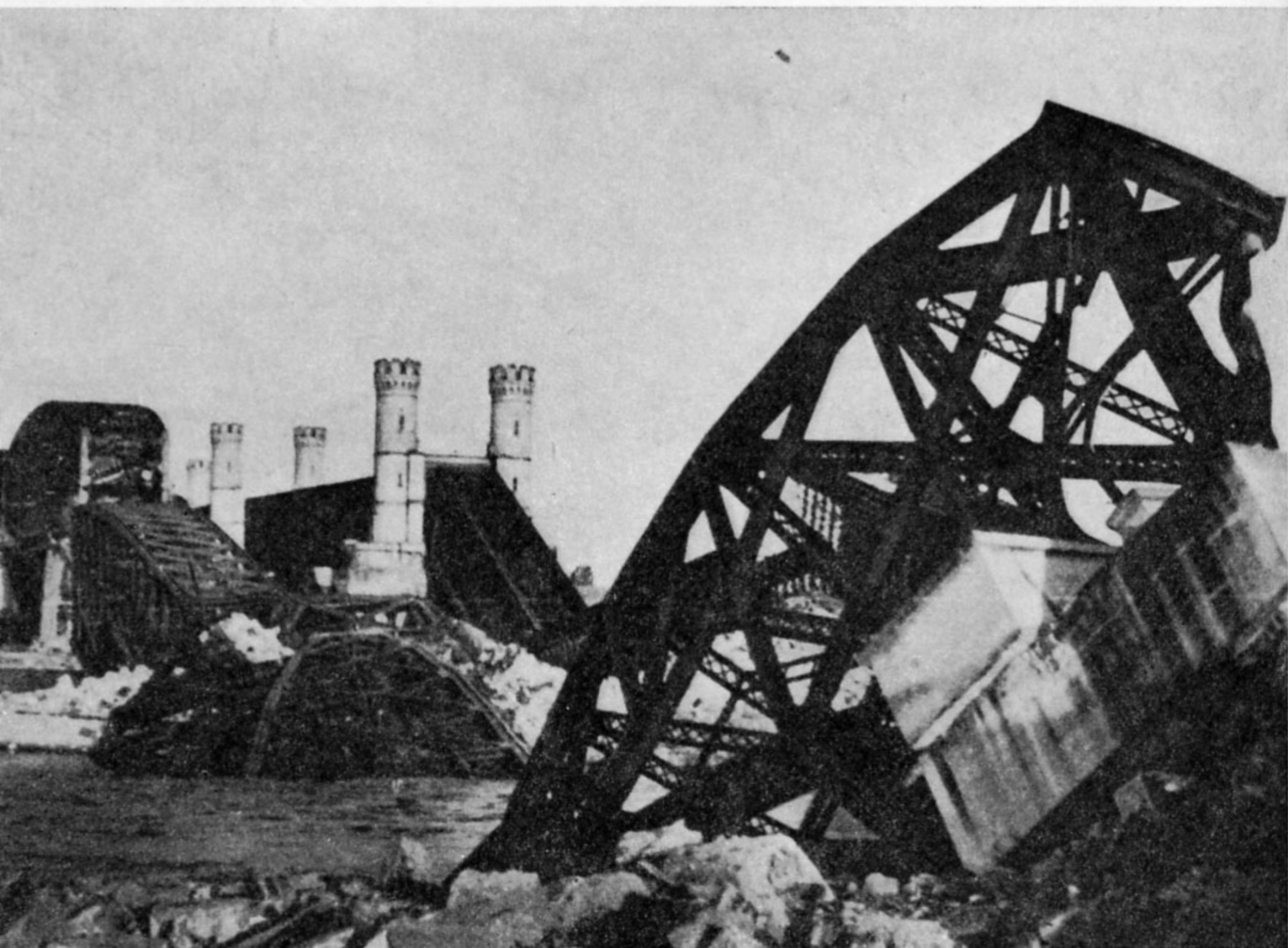
133. Zniszczony most kolejowy pod Tczewem
