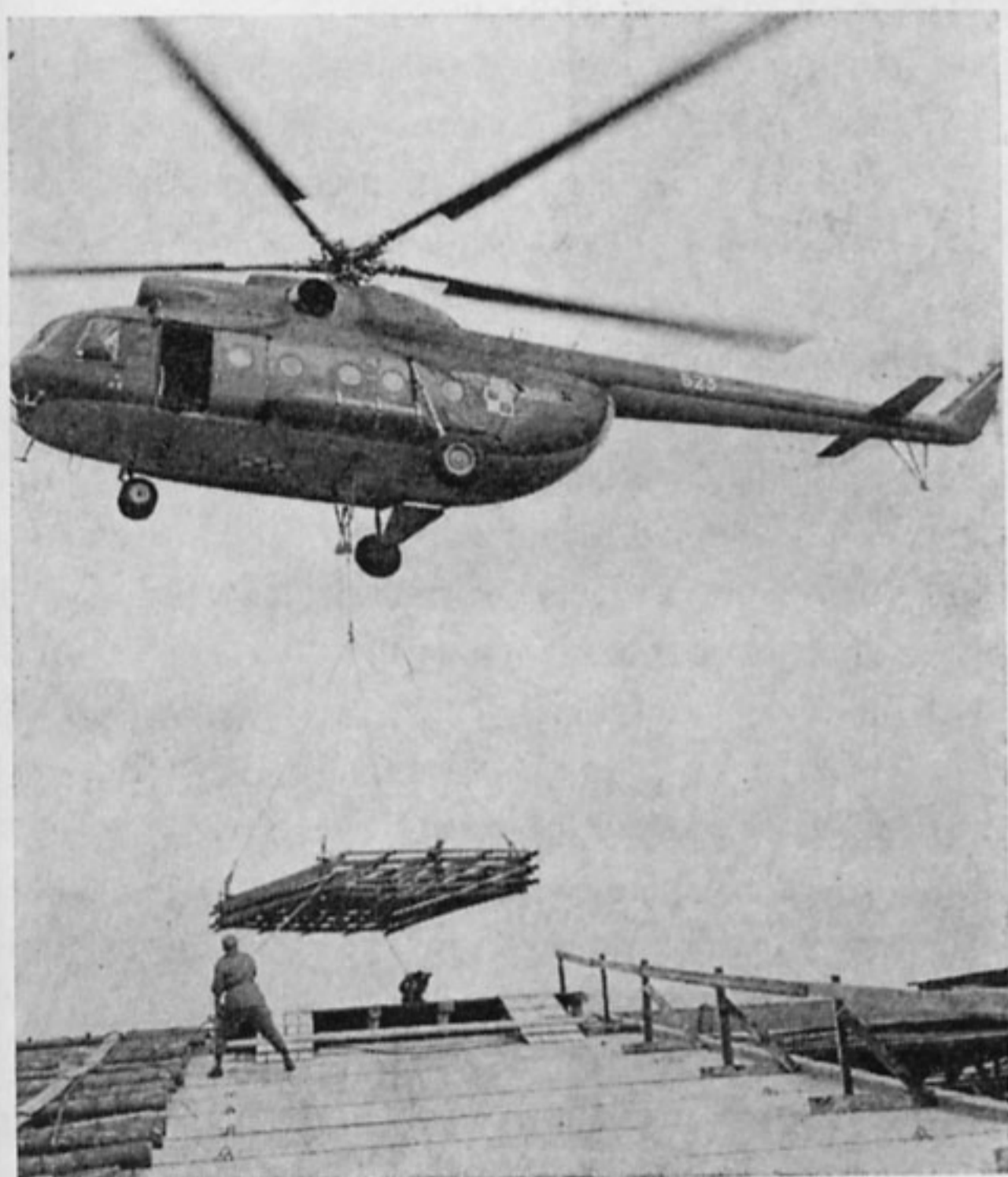
302. Montaż dachu lokomotywowni Warszawa Grochów
