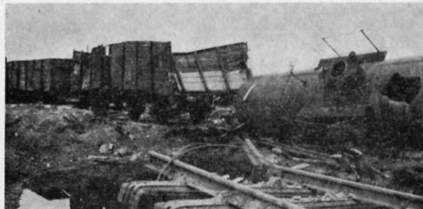
156. Zniszczony tabor kolejowy
