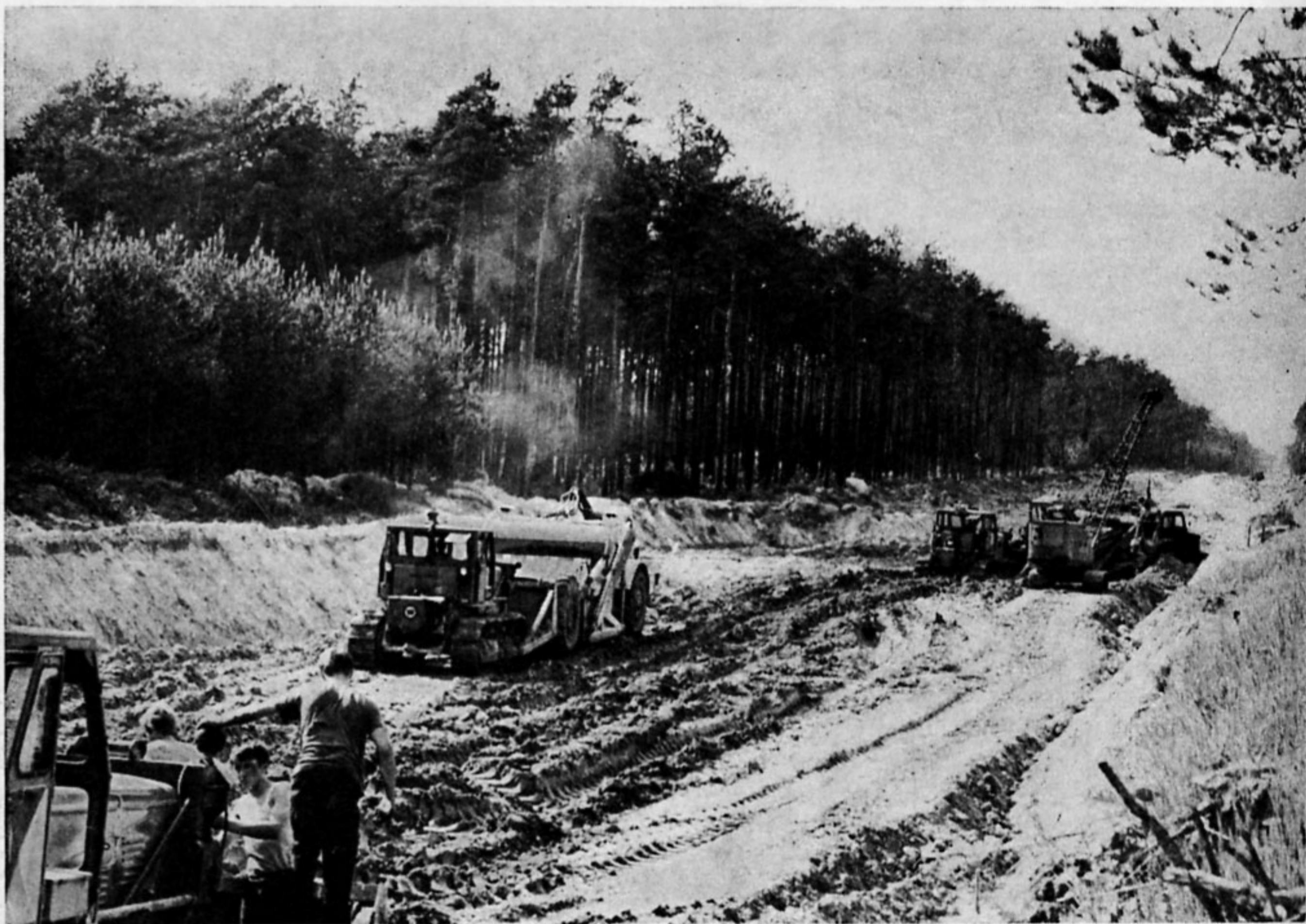
175. Budowa linii Kozłów—Koniecpol
