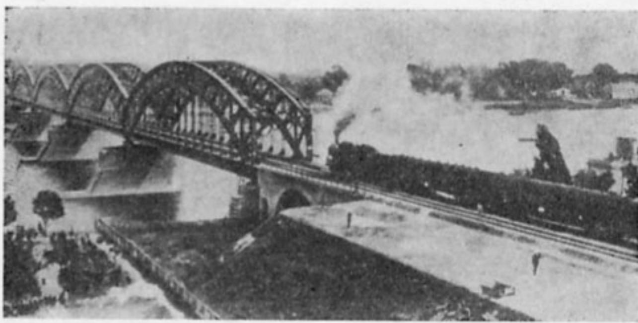
80. Most przez Wisłę na linii średnicowej w Warszawie
