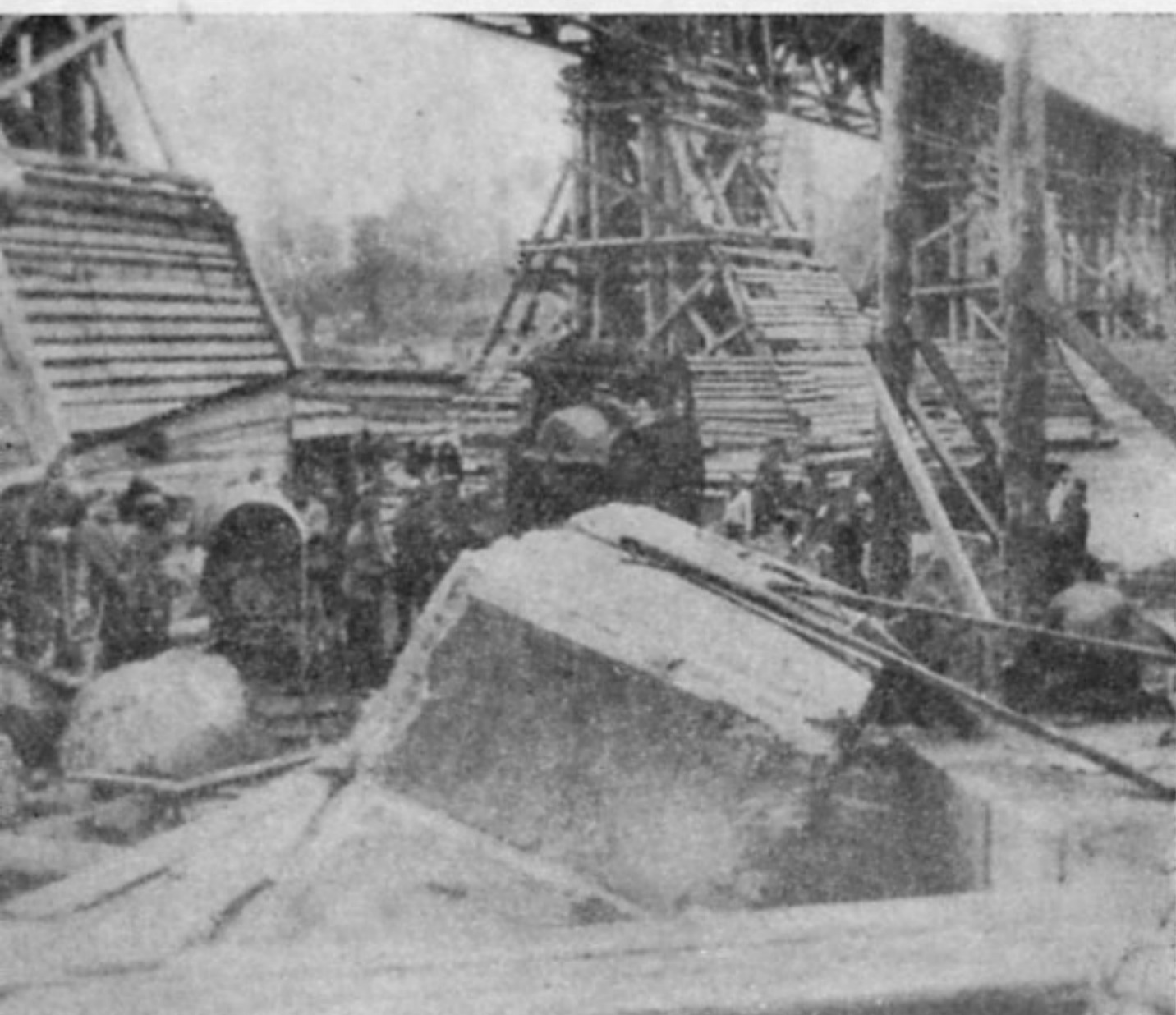
160. Odbudowa mostu na Wiśle w Toruniu
