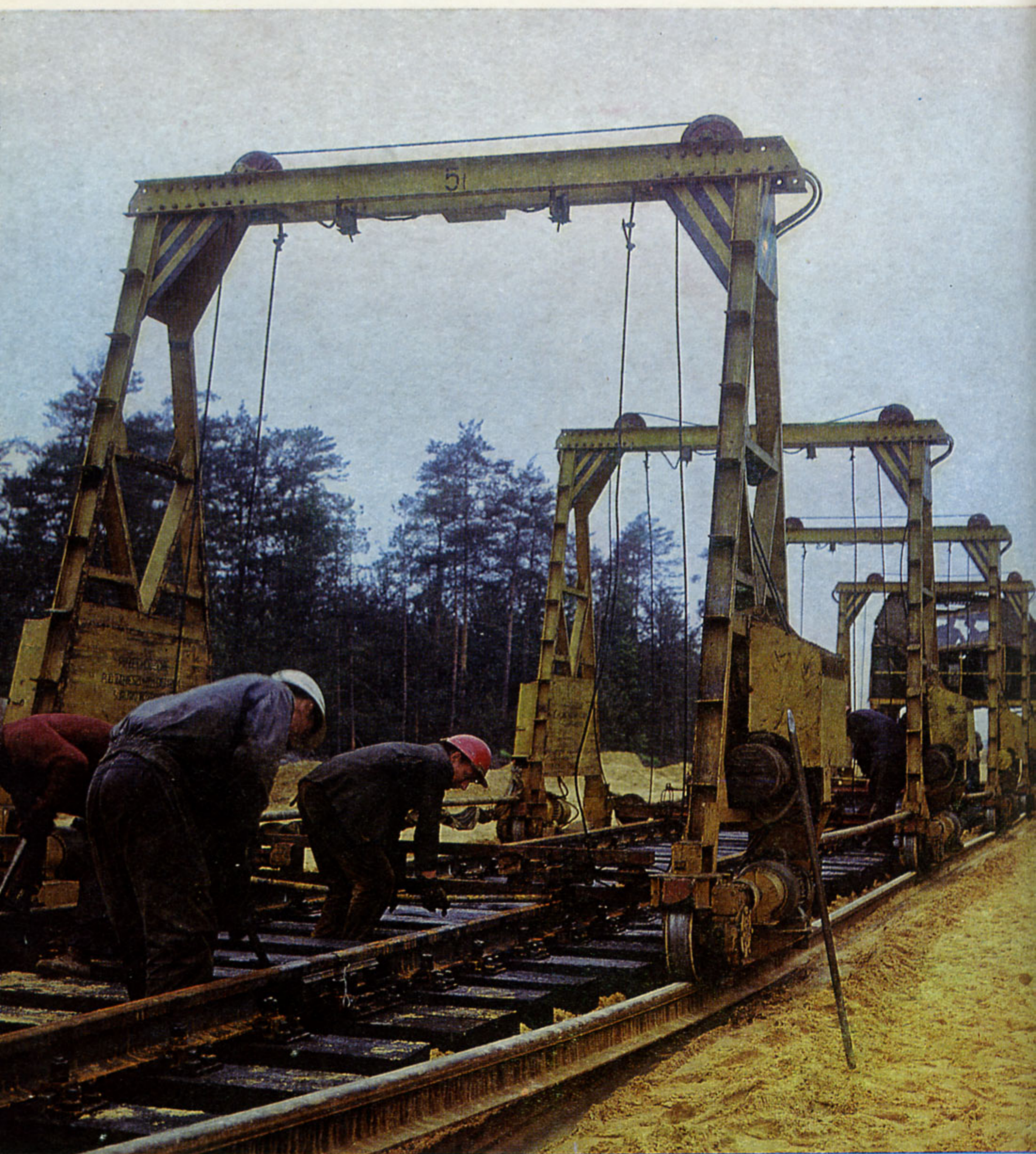
Układanie torów na centralnej magistrali kolejowej
