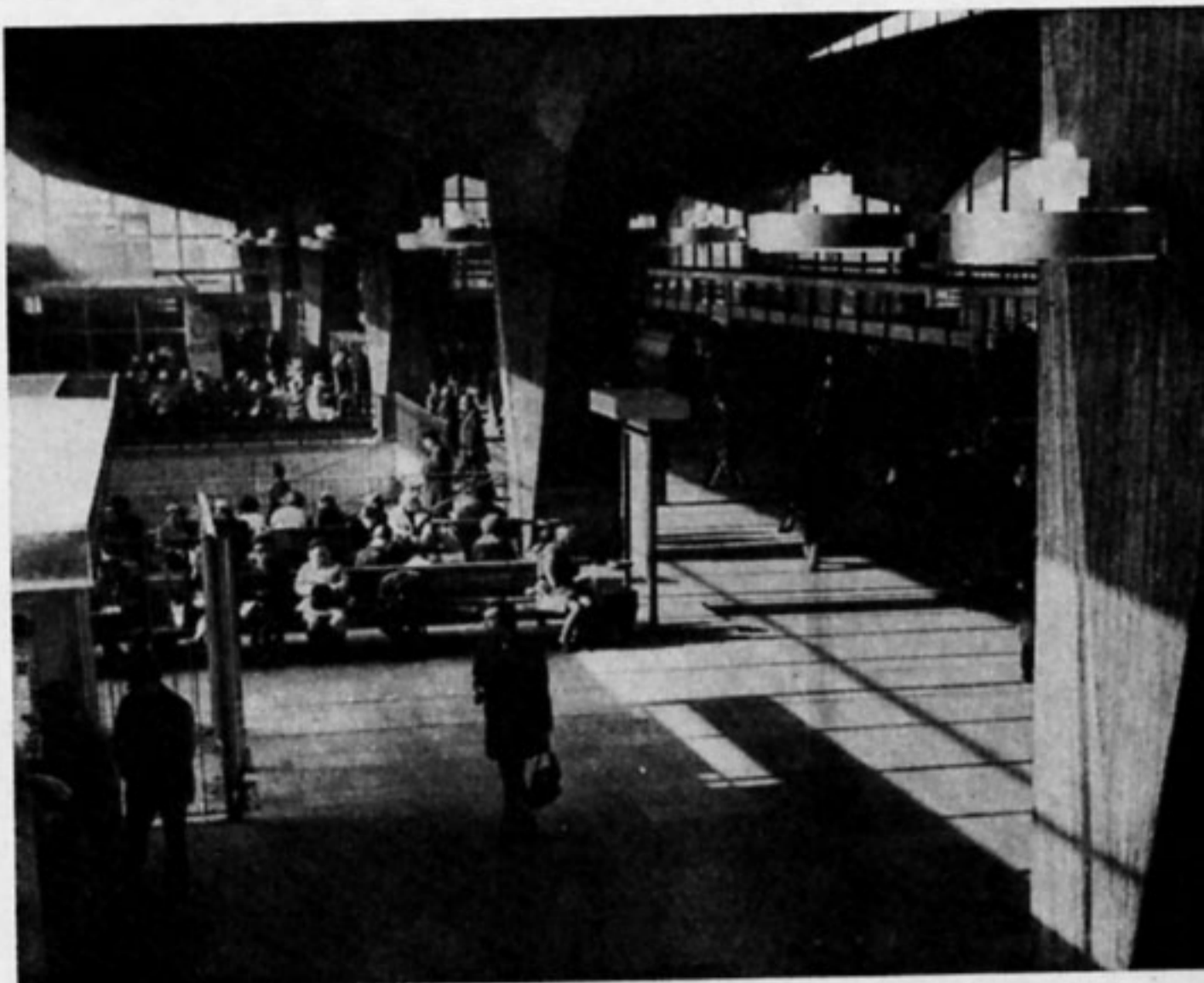
187. Hala dworcowa w Katowicach
