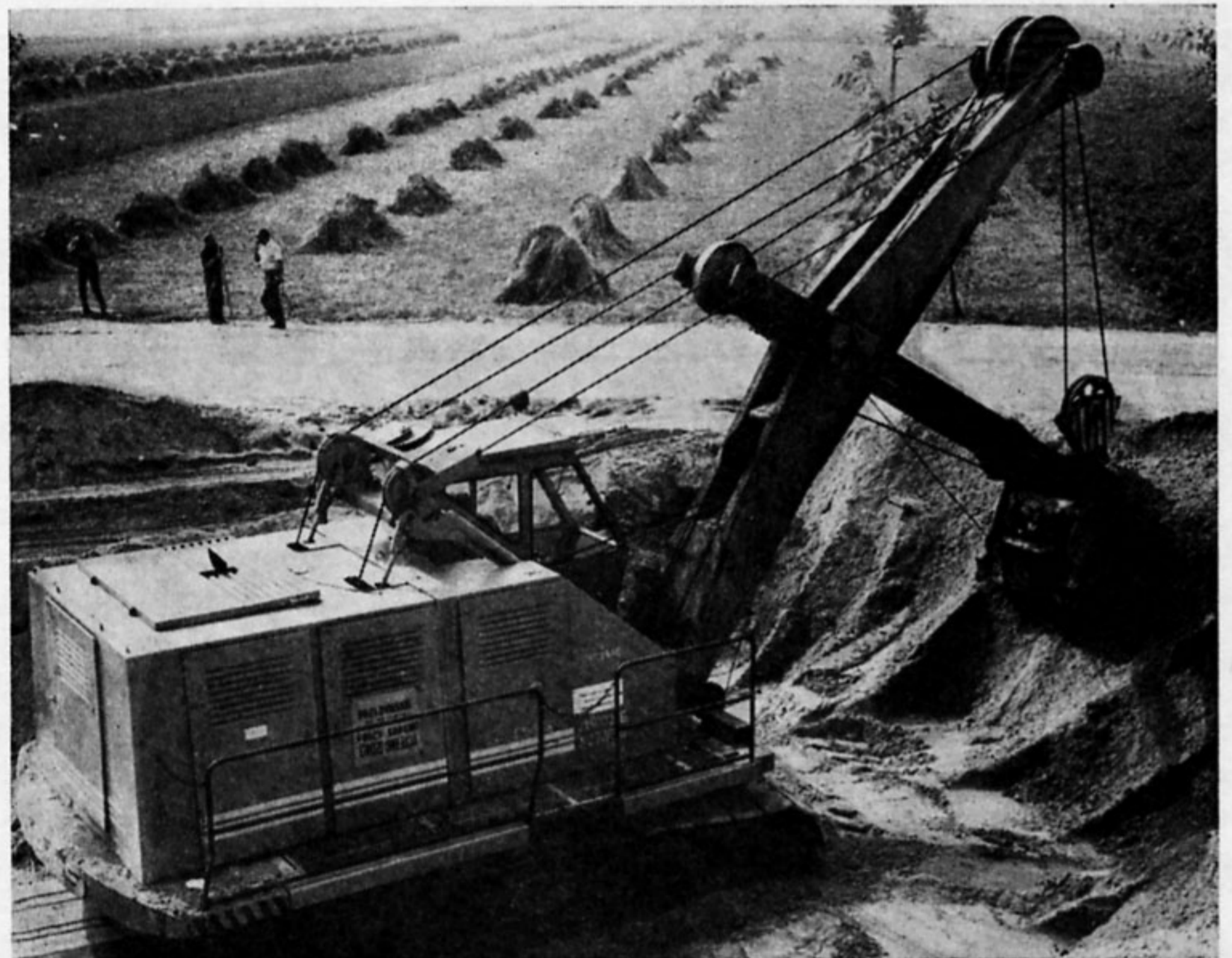
178. Rozpoczęcie robót przy budowie centralnej magistrali kolejowej
