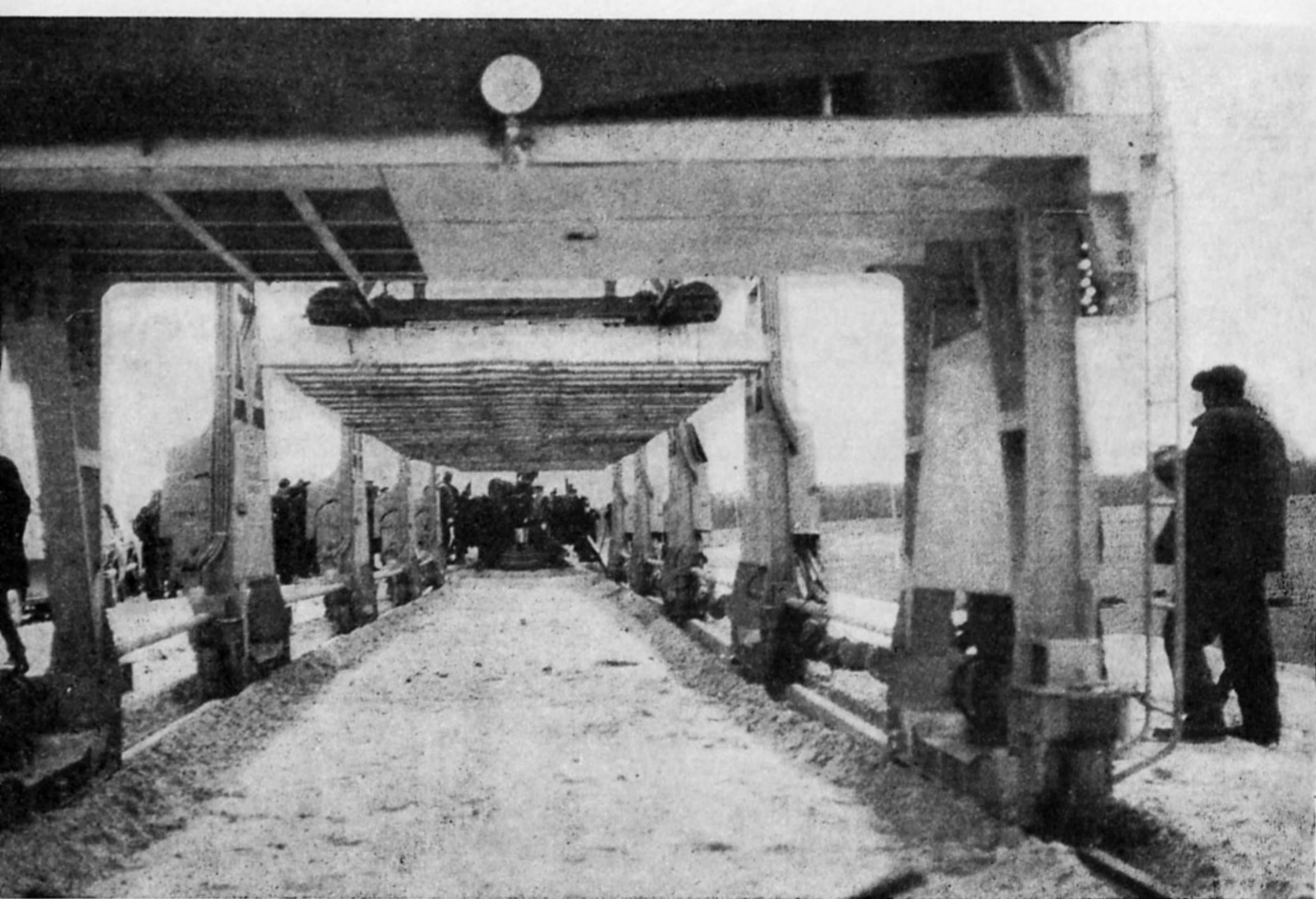
179. Układanie pierwszych przęseł toru na centralnej magistrali kolejowej
