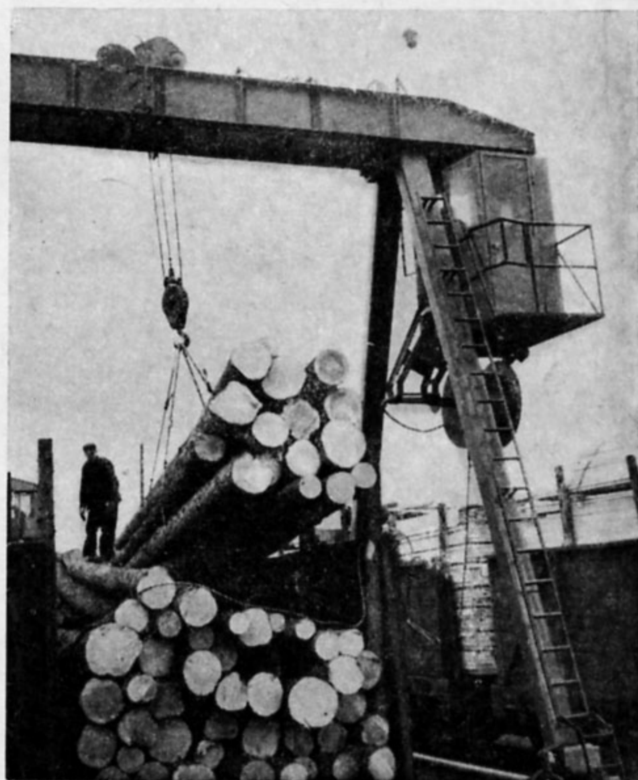
276. Przeladunek drewna przy użyciu suwnicy bramowej
