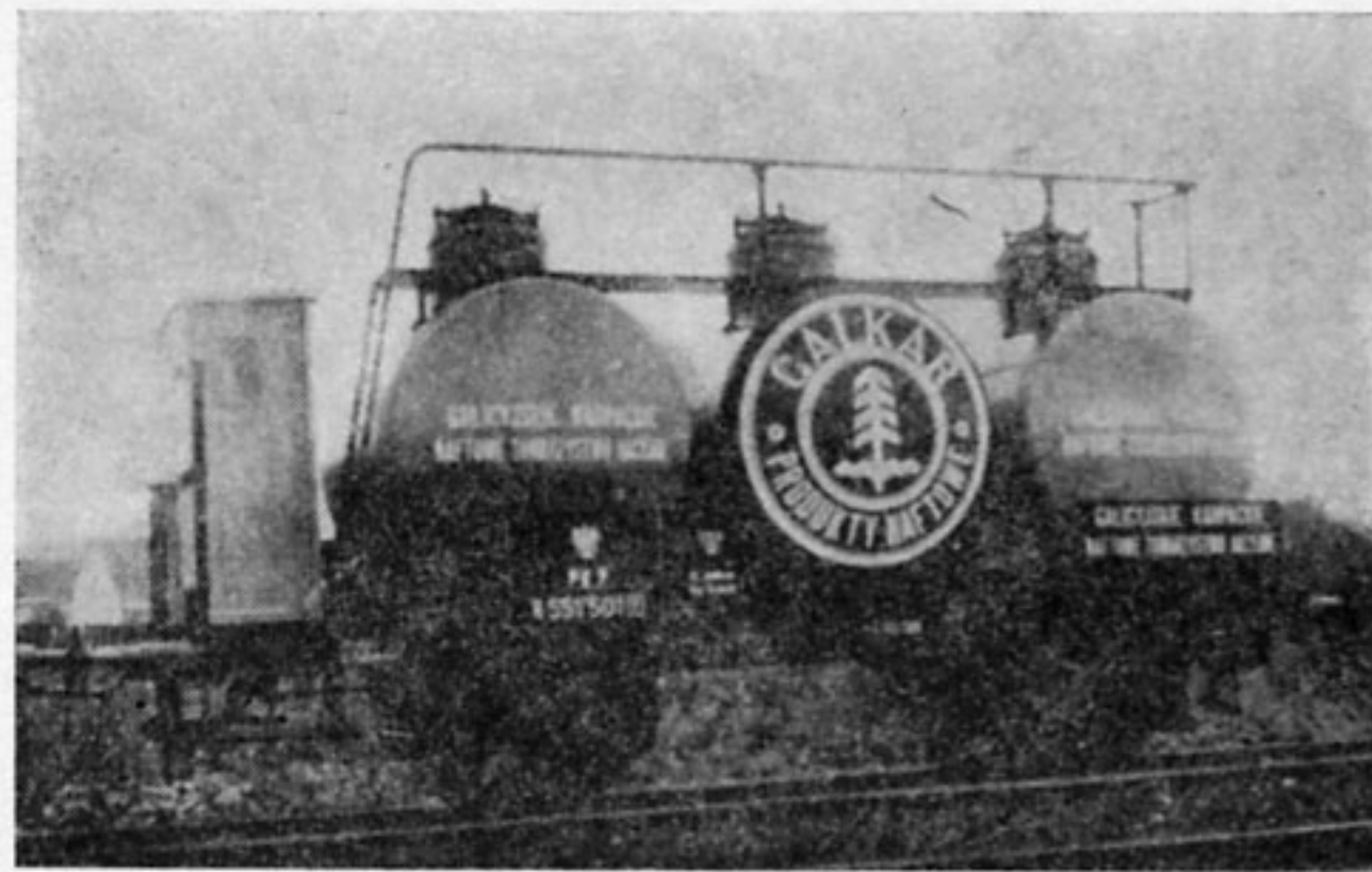
111. Wagon cysterna do przewozu produktów naftowych
