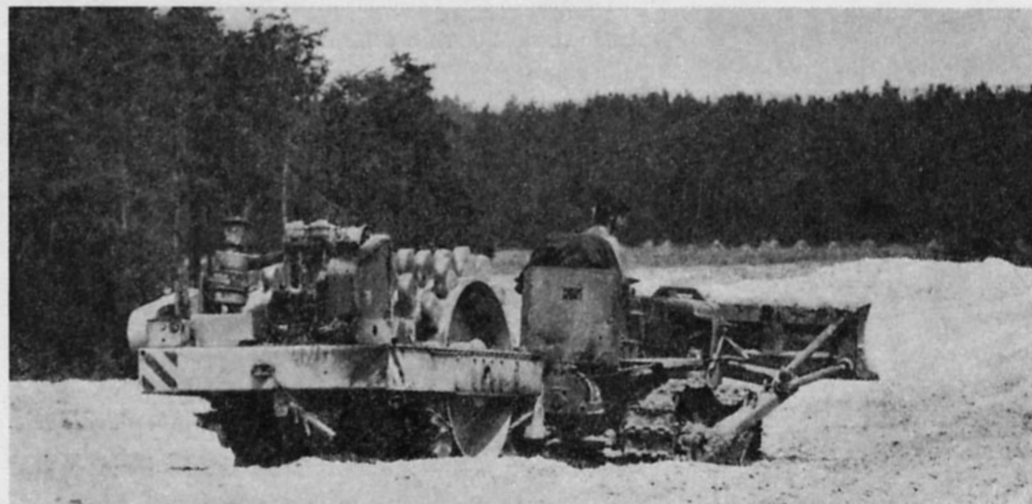
303. Zmechanizowane roboty ziemne przy budowie centralnej magistrali kolejowej
