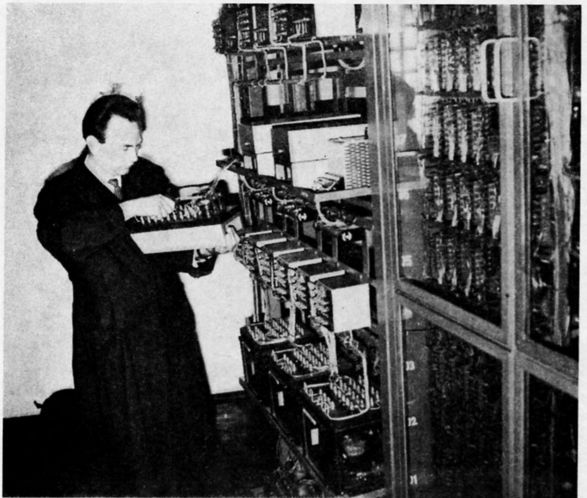
259. Konserwacja urządzeń przekaźnikowych w nastawni
