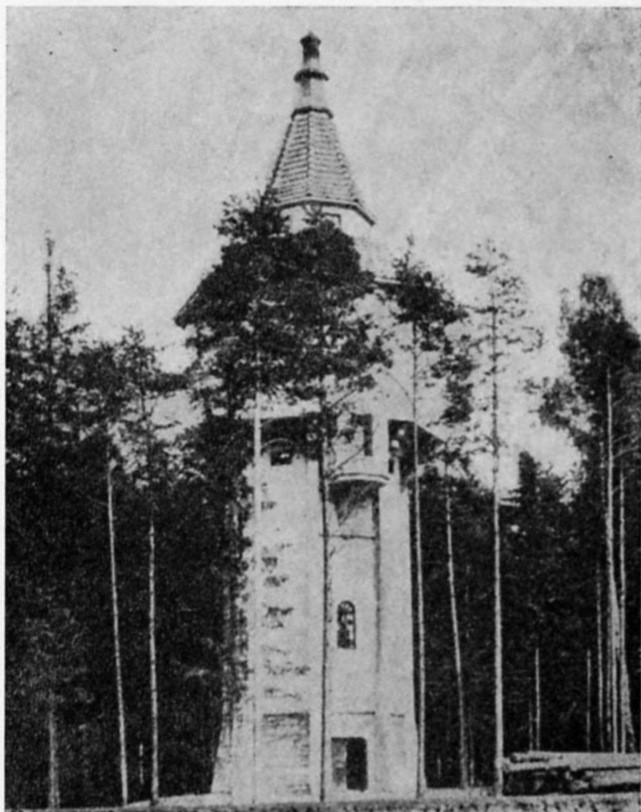
85. Wieża ciśniń na linii Kalety—Podzamcze
