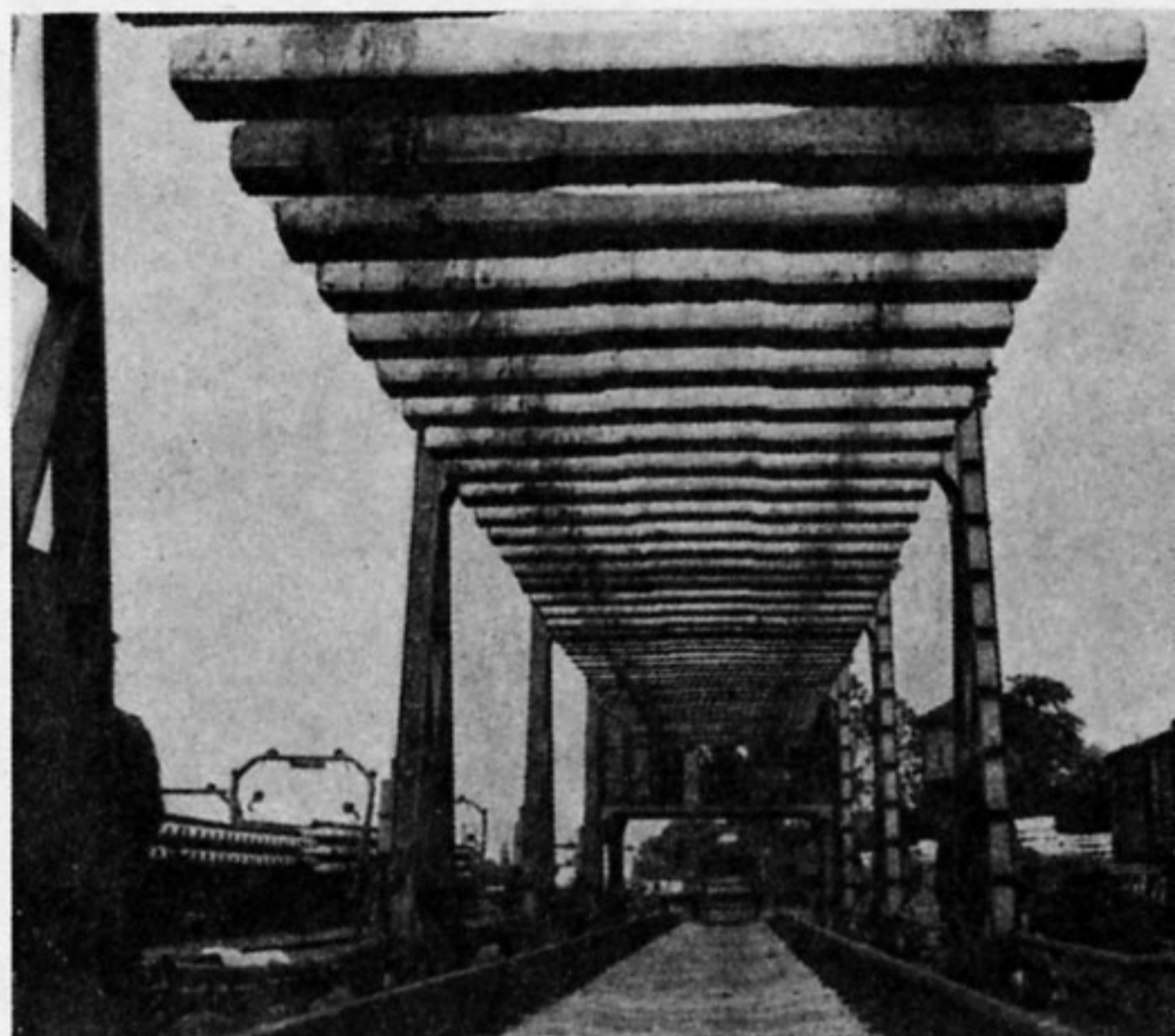
244. Suwnica bramowa do układania przęseł torowych
