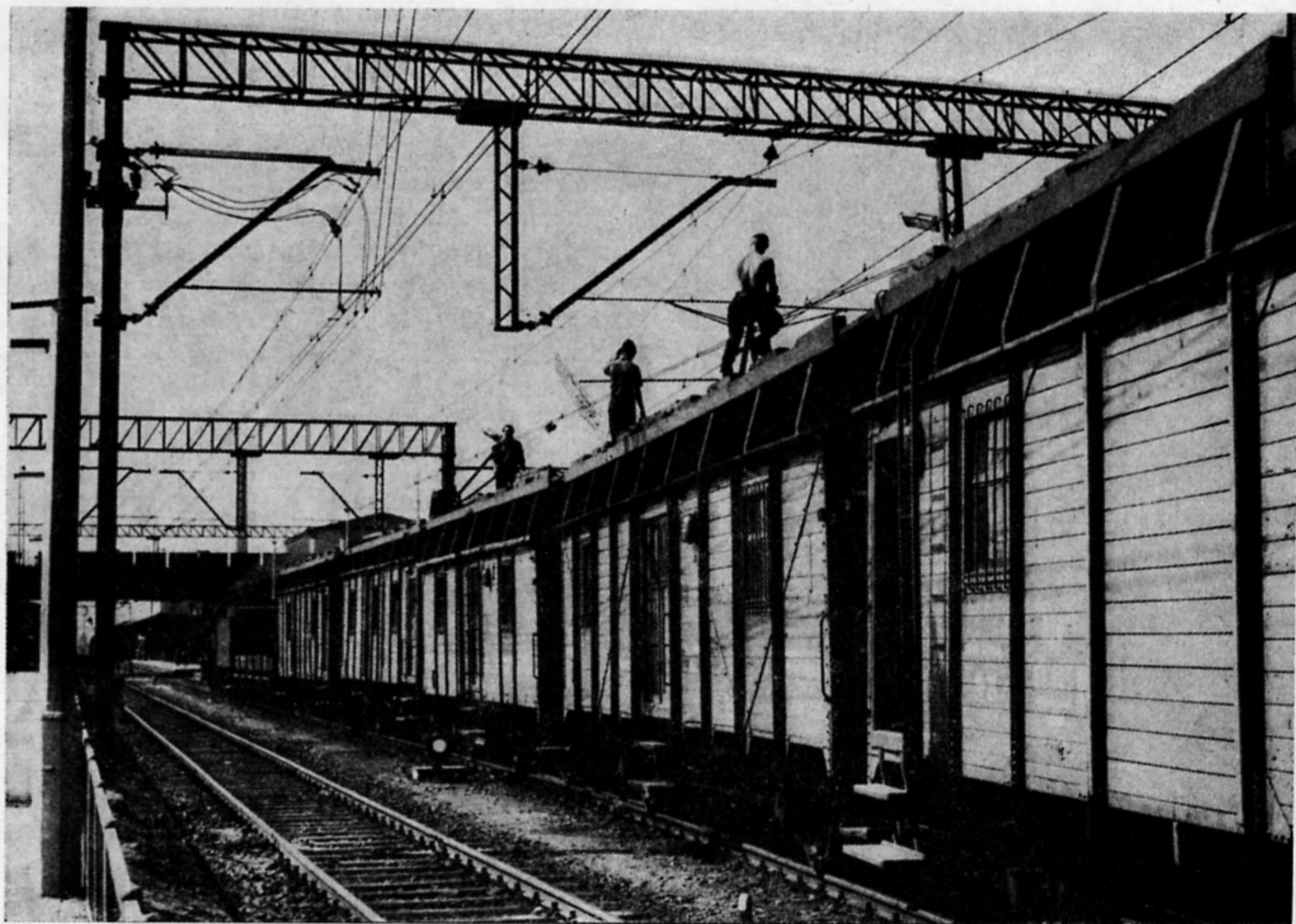
172. Pociąg montażowy do utrzymania sieci trakcyjnej
