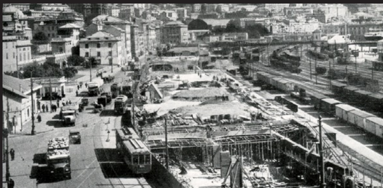
La stazione di Dinegro è situata appena sotto il piano stradale e da entrambi i lati della strada sono situate le fermate dei bus e filobus per Sampierdarena e il centro città che consentono un veloce interscambio. Sotto: una foto degli anni '30 in cui si vede la zona di Dinegro e la costruzione dei magazzini che sessant'anni dopo serviranno per la metropolitana
