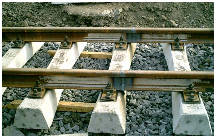
Figura 19 - Saldatura delle rotaie
