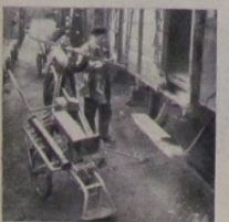
Remise sur place d'une porte railante - ou premier plan, le chariot de dépannage avec, à l'avant, son dispositif pour franchir les rails.
