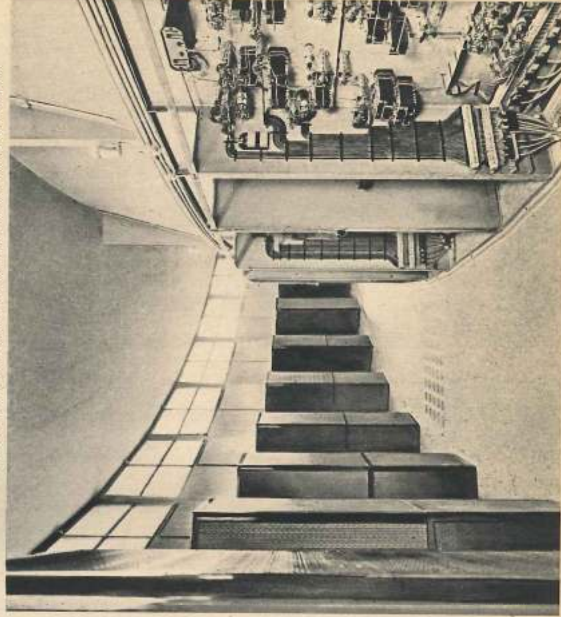
Vue de la galerie de pourtour de la salle de commande centralisée.
