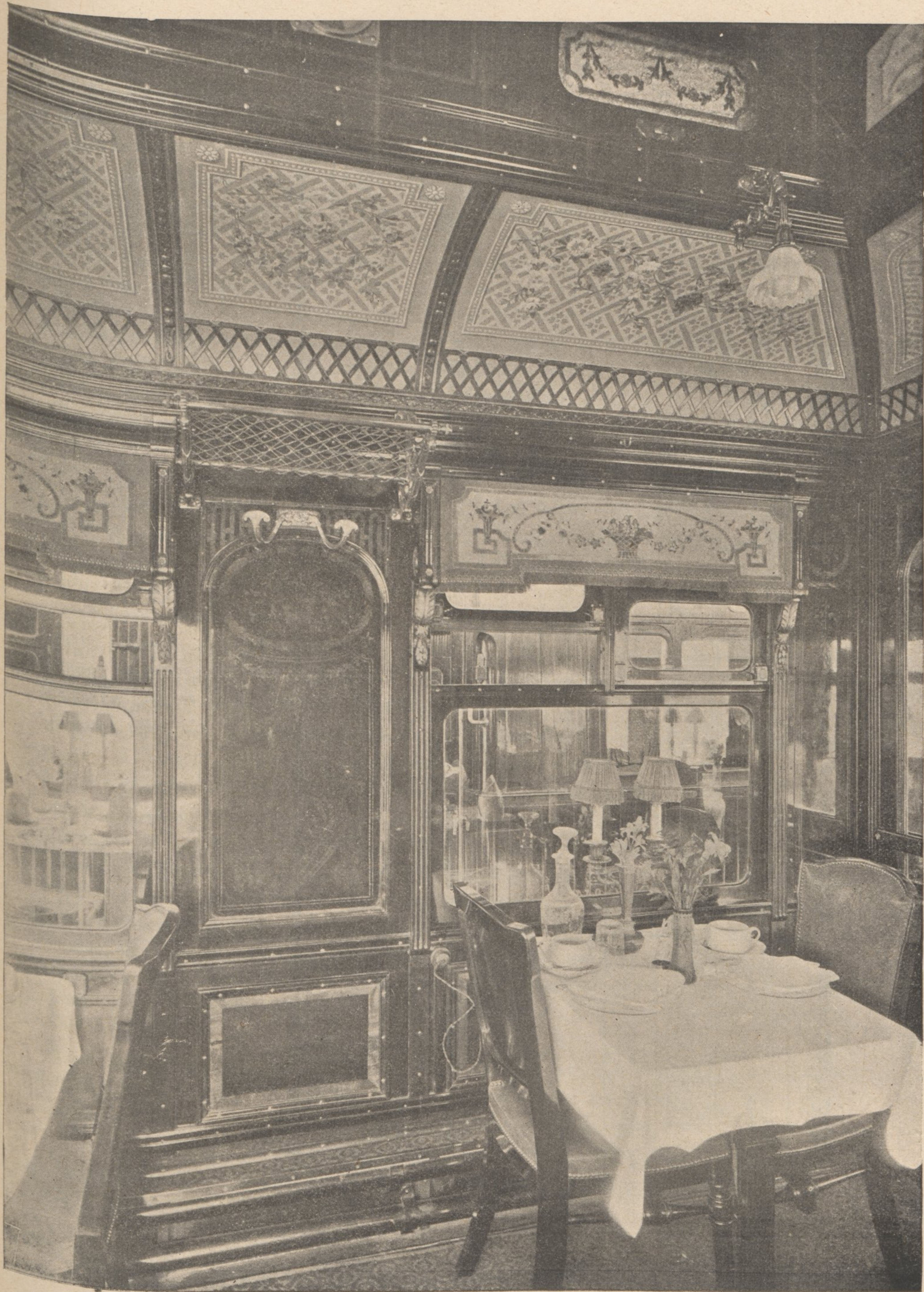
VOITURE-RESTAURANT A 6 ESSIEUX. — Salle à manger.
