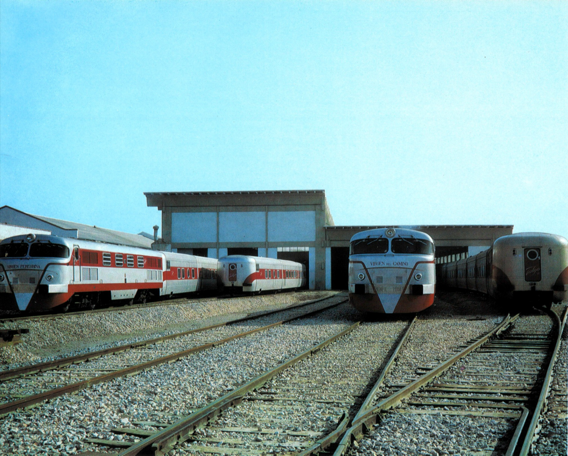
Base de conservación, reparación y mante- nimiento de los trenes Talgo en Aravaca (Madrid).
