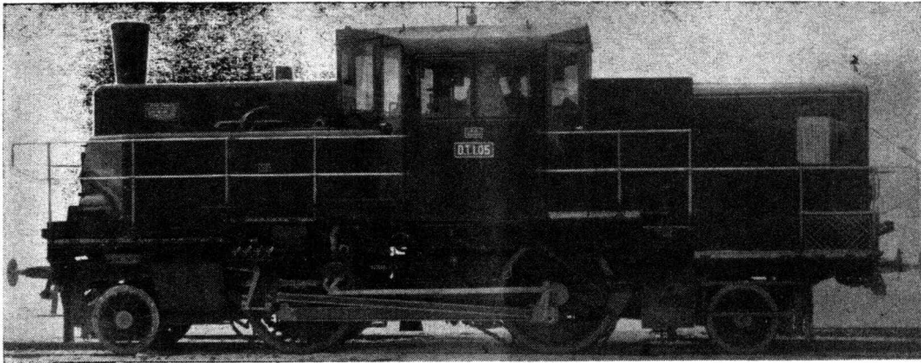
Abb. 7. 1B1-Gepäcks-Dampftriebwagen Reihe D. T. 1 der Oe. B. B. mit neuartiger Lentzventilsteuerung (Wälzhebel). Gebaut von der Wiener Lokomotiv-Fabriks-A. G. Wien-Floridsdorf. 2. Lieferung.
