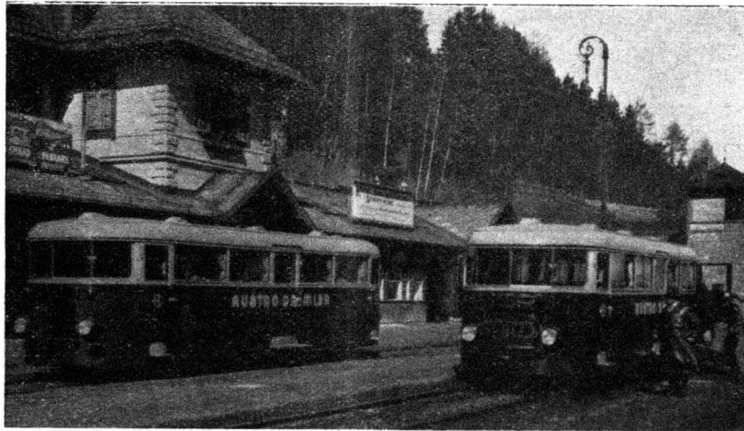
Bild 4. Zwei 80 PS Austro-Daimler Zahnradgetriebe, in der Station Semmering, der linke mit Flüssigkeitsgetriebe, der rechte Wagen mit Zahnradgetriebe.
