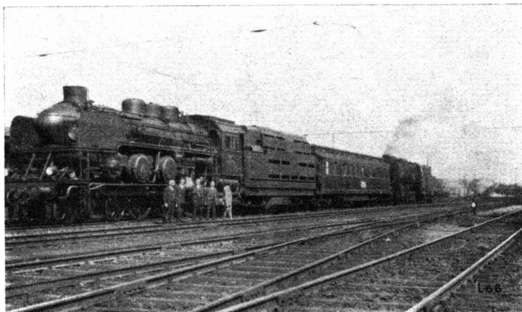
Fig. 5. L 66. Turbolokomotive mit Bremsmaschine auf der Versuchsfahrt.
