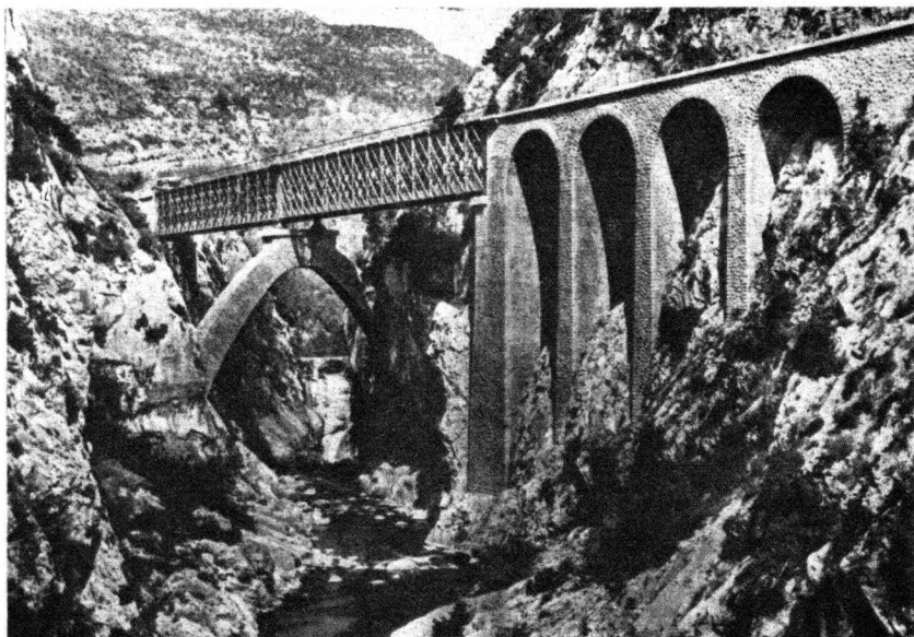
Abb. 3. Viadukt de la Bevera, 2 Eisenbrücken von je 45.3 m Spannweite auf einem Quergewölbe von 25 m Weite.
