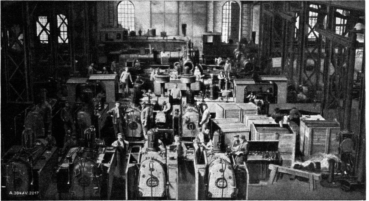
Abb. 2. Ansicht der Montierungshalle in der Lokomotivfabrik A. Borsig in Berlin—Tegel mit 39 seemäßig zu verpackenden Doppelfeldbahnlokomotiven für Japan.
