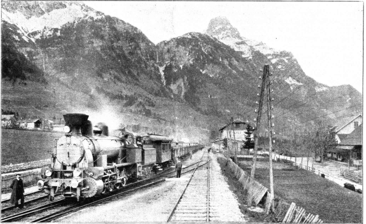
Abb. 14. Bremsprobezug in der Station Braz der Arlbergbahn.
