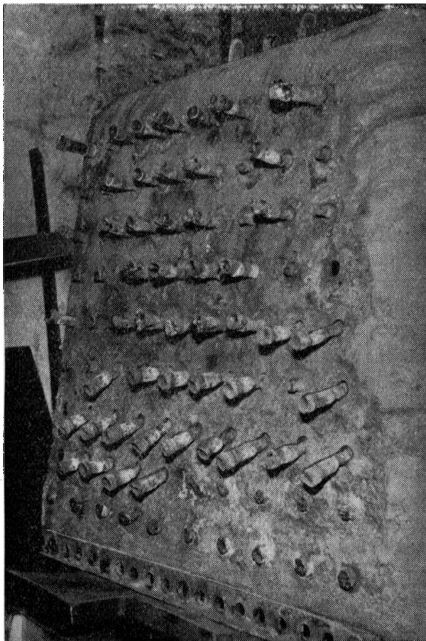
Bild 22. Stark abgezehrte und gelockerte Stehbolzen
